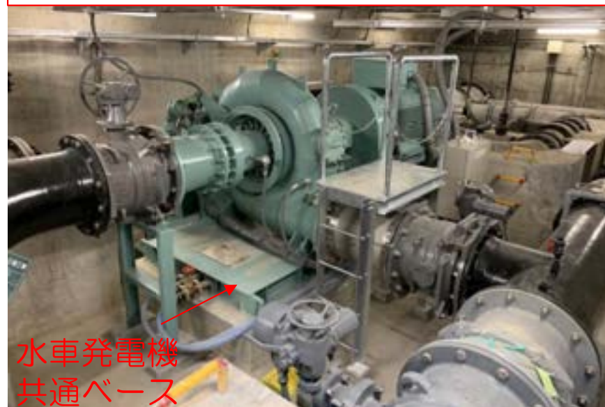
別水道発電地点 フランス水車設置状況
