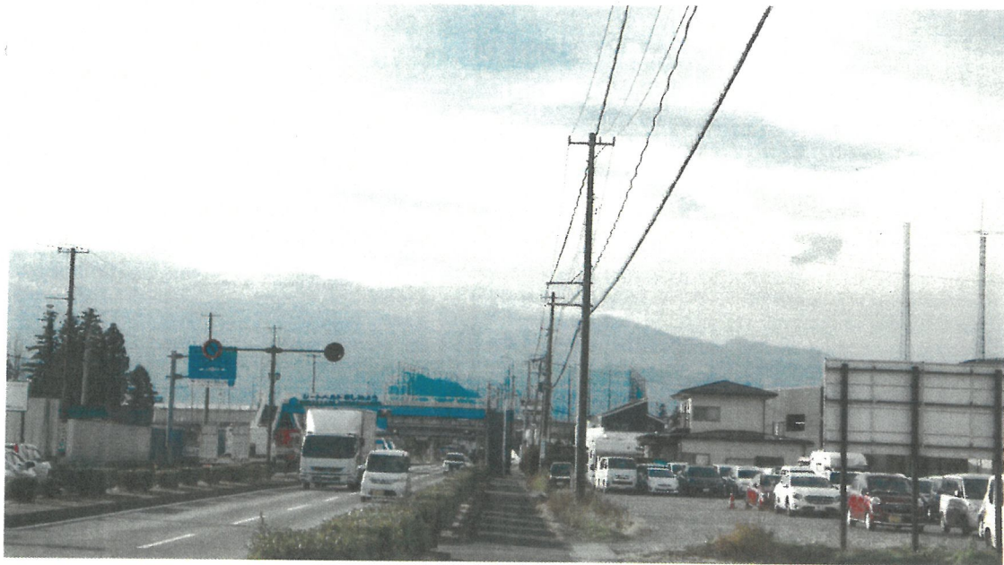
写真7 国道115号沿いからの見え方
