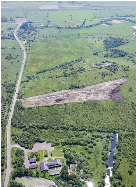
日本エコロジーによる釧路市北斗での太陽光発電施設の建設現場。下側には猛禽類医学研究所などの施設がある=8月13日（本社ヘリから、小川正成撮影）
