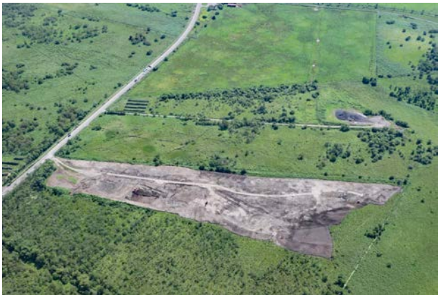
大阪の日本エコロジーが進める釧路市北斗の太陽光発電施設の建設現場=8月13日（本社ヘリから、小川正成撮影）
