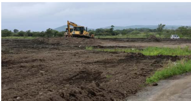
大坂市の事業者が釧路湿原周辺で建設を進める大規模太陽光発電所の工事現場=8月26日（小松巧撮影）
